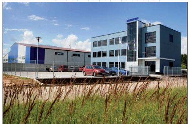
Рис. 1. Инженерно-административное здание компании RIFAS UAB
