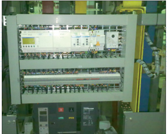
Рис. 4. Схема АВР спроектированная в PC|SCHEMATIC
